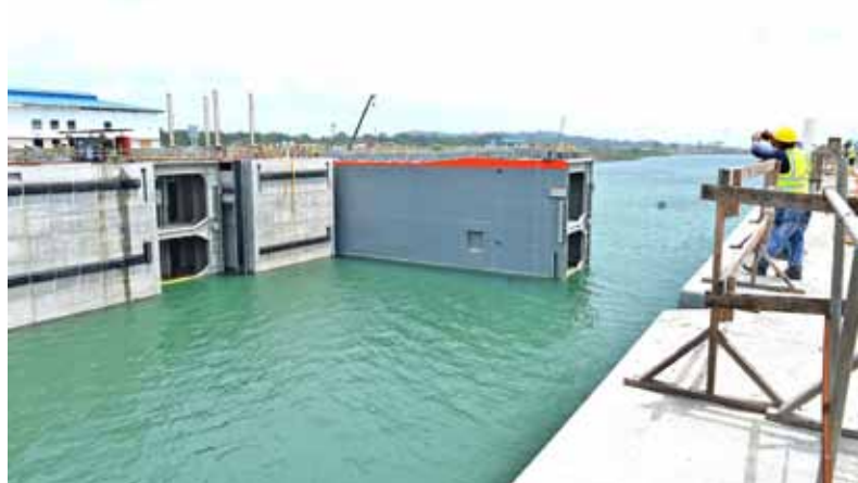
Zkouška posledních z 16 posuvných vrat o hmotnosti 750 t
