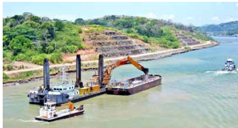
Jedno ze 40 velkých plovoucích rýpadel, nasazených k hloubení a rozšiřování navigačních kanálů a Gatunského jezera
