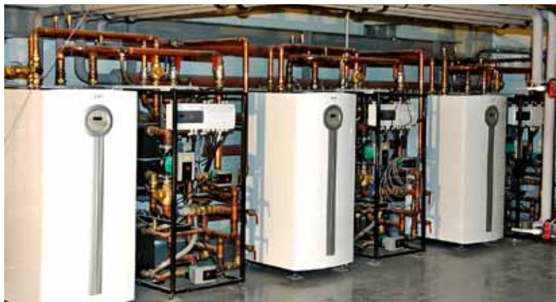
Chladicí moduly VESKOM CM - řešení, které umožňuje chladit a topit současně - je chráněno patentem č. 305815
