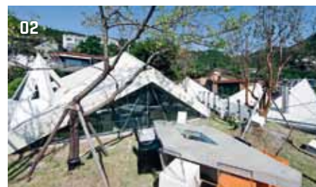
02 > Střecha je vybavena nejen příhodným posezením, zastíněnými kouty, ale pochopitelně i zahradou
