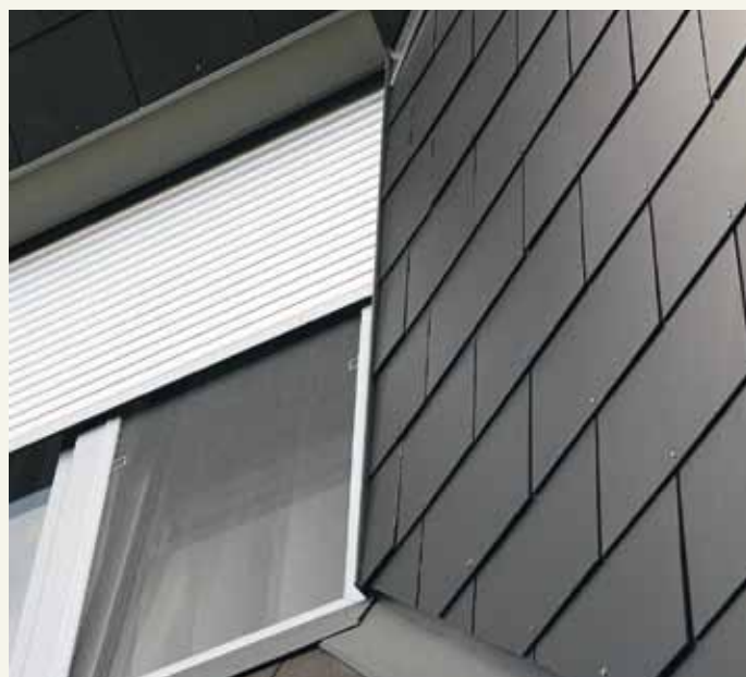
Obklad z desek Cembit Express chrání jihovýchodní fasádu v 2. NP
