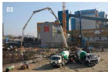
03 > Čerpání betonu probíhá nejčastěji pomocí mobilních čerpadel na beton
