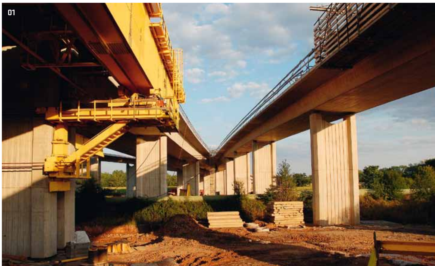
01 > Na přemostění se sjezdovými a nájezdovými rampami k rondelu bylo celkem uloženo zhruba 40 000 kubíků betonu
