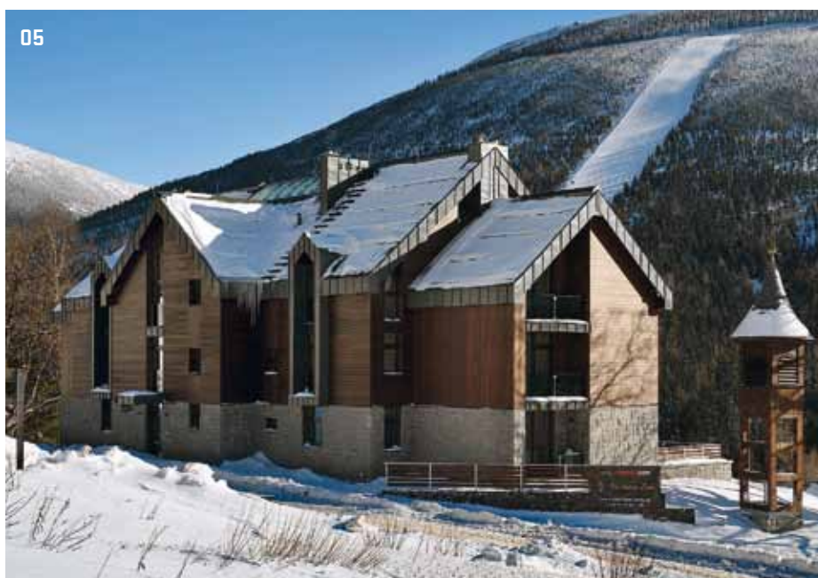
05 > 1. PP a 1. NP je obloženo kamenným obkladem, 2. NP a podkroví mají dřevěnou fasádu. Střešní krytina je z titanzinkového plechu.
