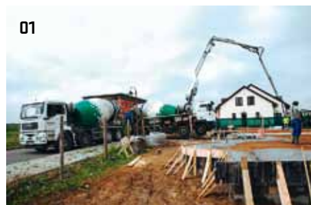
01 > Čerpání betonu na základy rodinného domu – pumomix
