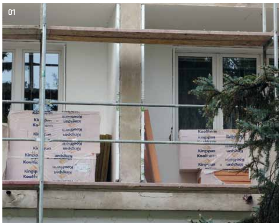
01 > Deska Kingspan Kooltherm® K5 je izolační deska z rezolové tvrdé pěny, opatřená na jedné straně uzavřenou černou hliníkovou fólií a na druhé straně mikroperforovanou hliníkovou fólií plnící funkci parozábrany
