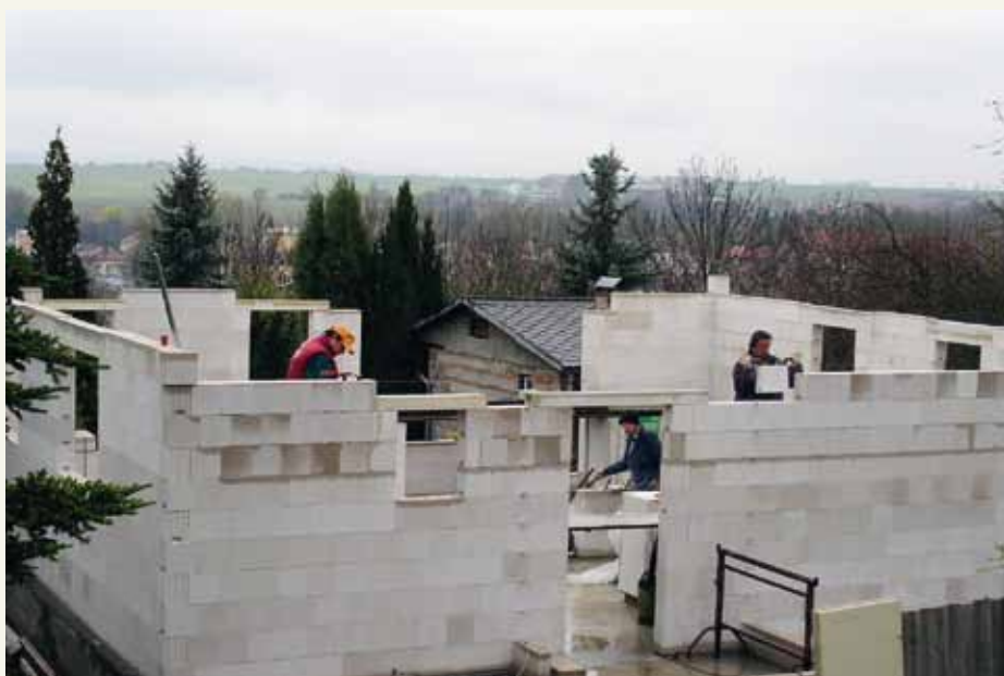
Díky přesnosti vápenopískových bloků je možné jednoduché a přitom čisté zhotovení masivního zdiva
