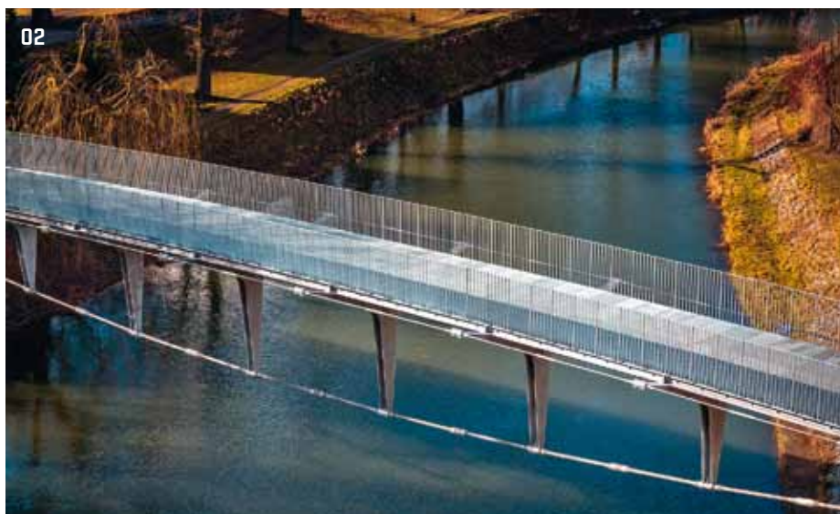
02 > Příčnice jsou kolmé ke kružnici zakřivené pátevní roury
