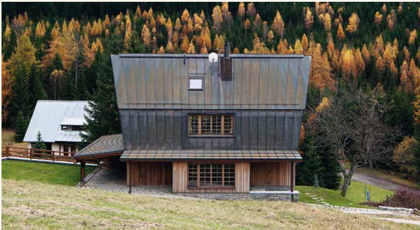
Hřeben střechy je delší než stavba samotná
