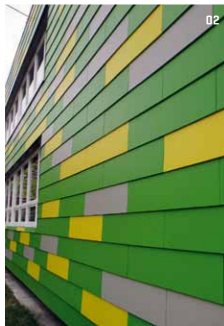
02 > Fasádu školy v Pezinku tvoří desky CETRIS® FINISH, kladené v tzv. loďovém systému
