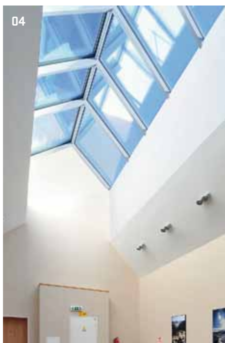
04 > Světlík v sedlové střeše
