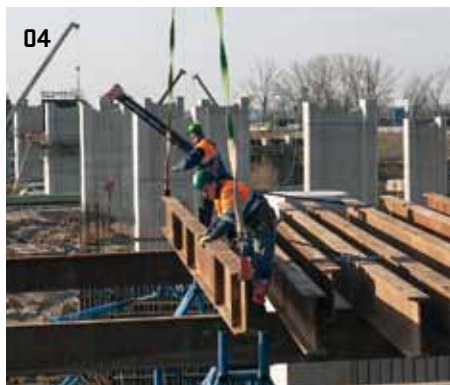
04 > Stavba podpěrné konstrukce z nosníků
