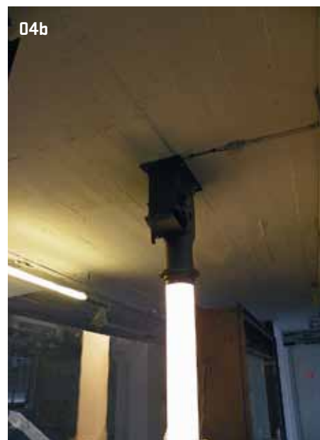
04 > Pozůstatky průmyslového zařízení: a, b) násypky přetvořené do atypických svislých lamp, c) obnovené tovární lampy
