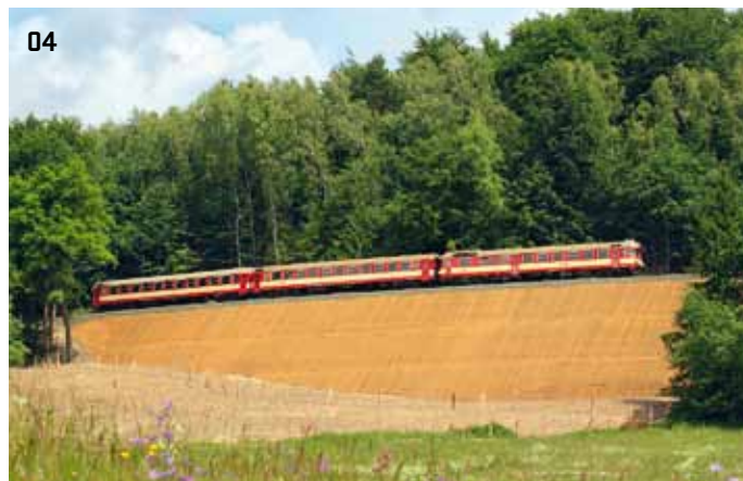
04 > Vyztužený svah pod kolejovým tělesem už je více než rok zatížen běžným provozem
