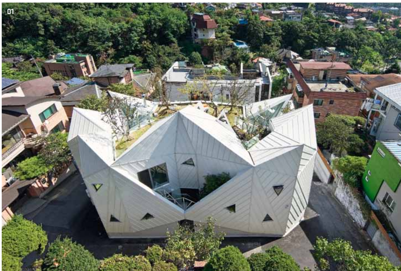
01 > Celý projekt si na topografické architektuře, nepravidelnosti a určité „nepříslušnosti“ k místu či příkrých stěnách doslova zakládá
