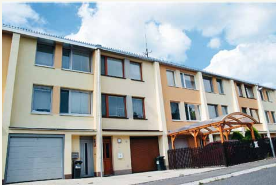
Dobře provedené zateplení prodlužuje životnost obvodové konstrukce
