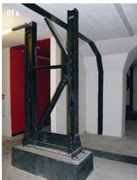
05 > a) přiznaná nýtovaná ocelová konstrukce, b) nová přístavba
