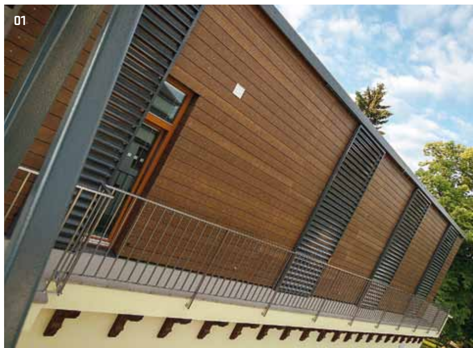
01 > Při rekonstrukci Centra sociálních služeb v Prostějově byly na opláštění nástavby použity lamely z desek CETRIS® PROFIL LASUR
