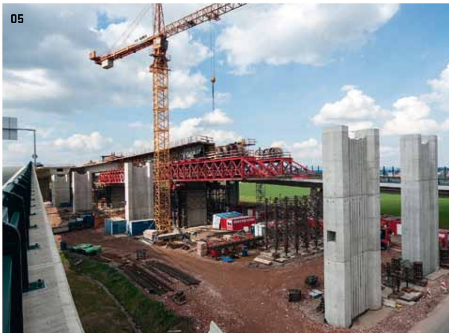
05 > Stavba podpěrné konstrukce
