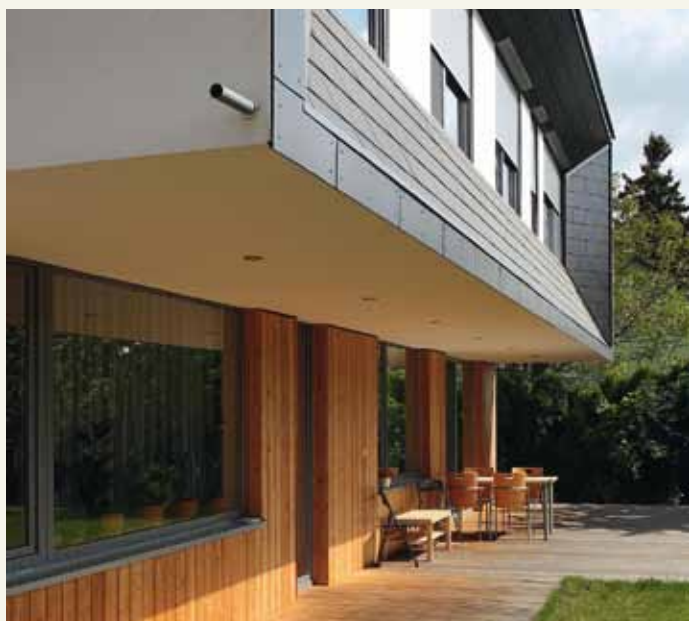
Druhé nadzemní podlaží domu je vykonzolované tak, aby chránilo terasu
