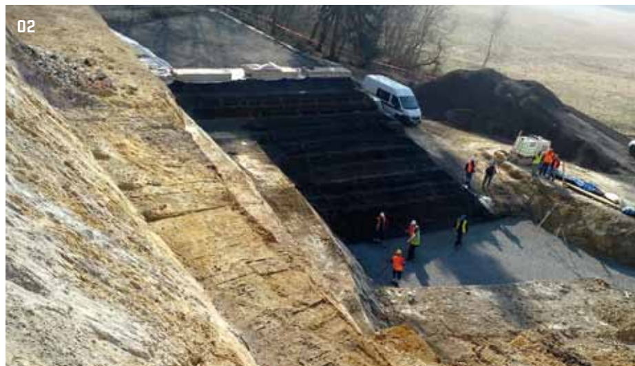
02 > Založení nového násypu
