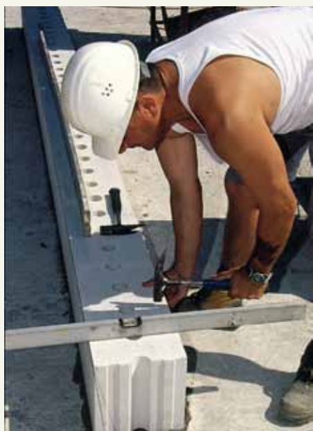
Zhotovení patní vrstvy – bloky BDF (240 mm)
