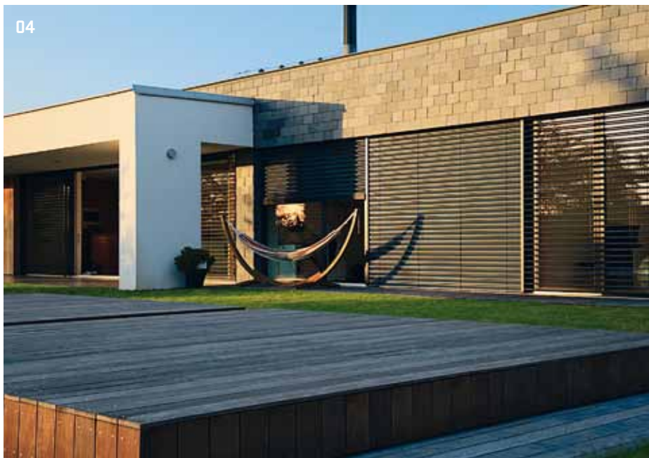
04 > Břidlicové šablony opláštění byly instalovány na laťovém roštu
