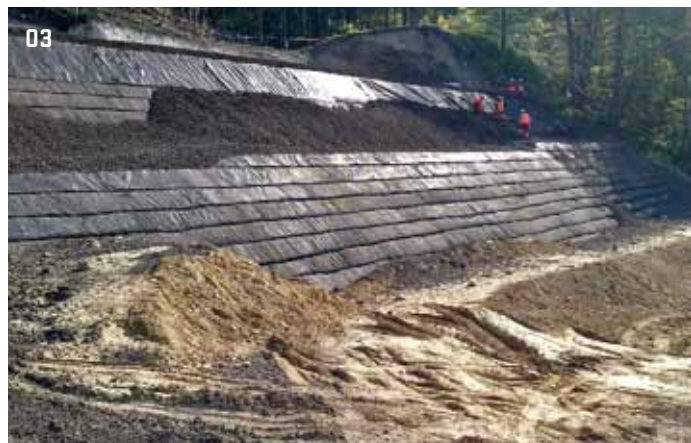
03 > Budování vyztužené konstrukce s vysokopevnostní polyesterovou geomříží
