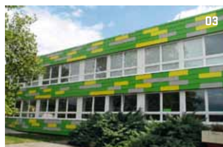
03 > Na stavbu byly dodávány desky nařezané na požadovaný rozměr včetně předvrtaných otvorů a sražené spodní vodorovné hrany z lícové strany
