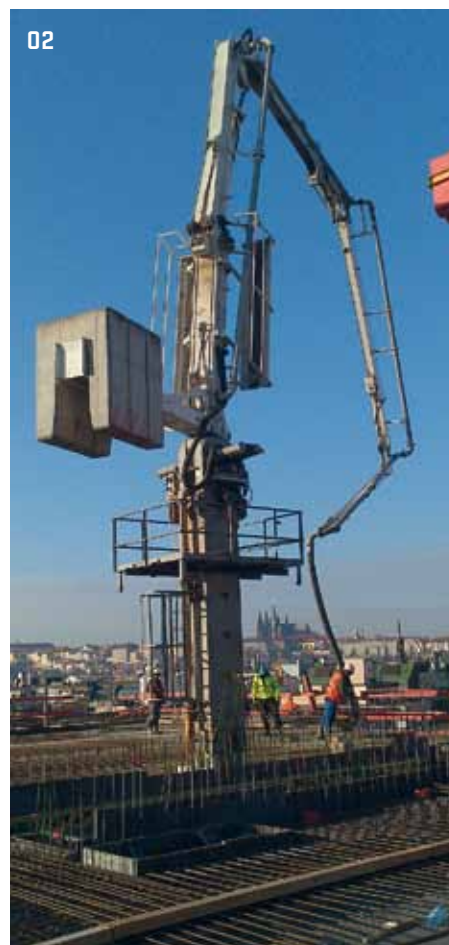
02 > Betonářské věže se používají na velkých stavbách
