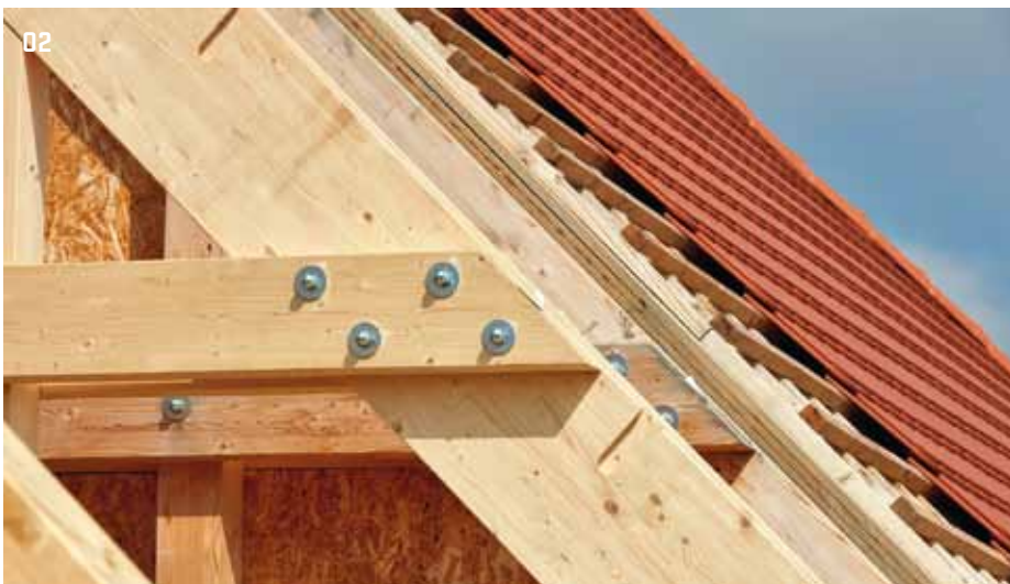
02 > První etapa rekonstrukce byla ukončena položením střešní krytiny
