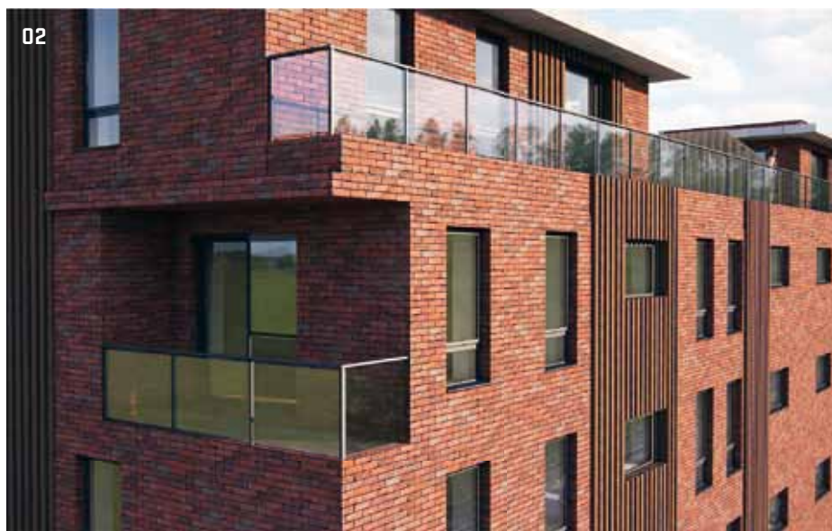
02 > Vnější stěny jsou v posledním podlaží zateplené izolací o tloušťce 180 mm, přízdívka na celém domě bude provedena z lícových cihel Terca
