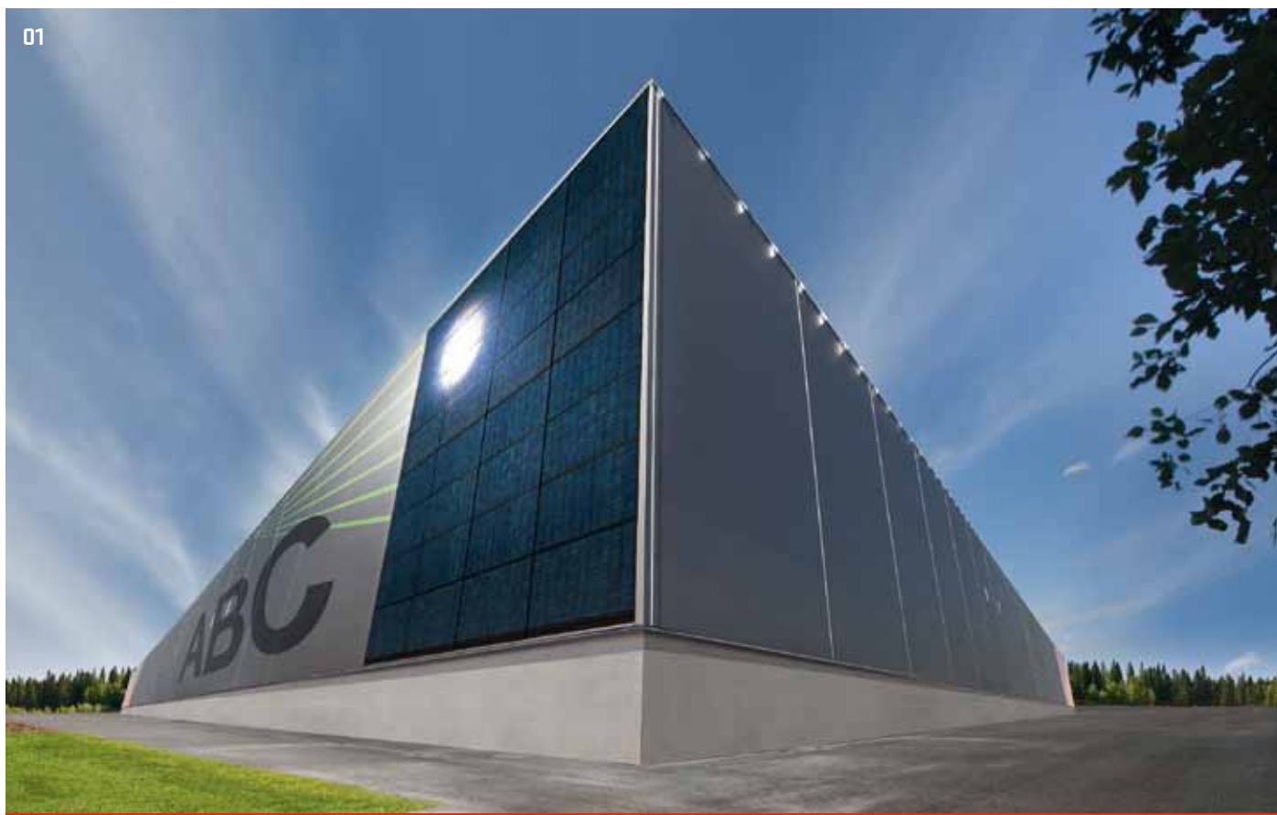
01 > Solární panely jsou instalovány na fasádě budovy pomocí kotvicího systému vyvinutého společností Ruukki
