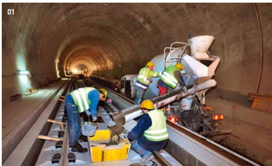
01 &gt; Montáž systému STA v tunelu
