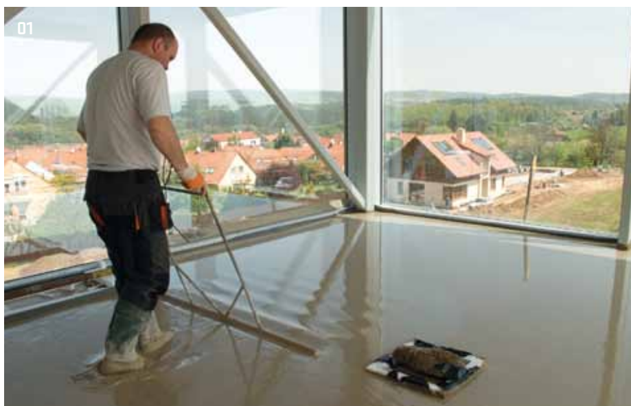
01 > Andyditové potěry se při zrání nesmršťují a nekroutí
