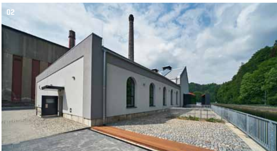
02 > Povrch chodníků a parkovacího stání byl vydlážděn žulovými kostkami, na ostatních komunikacích je zámková dlažba
