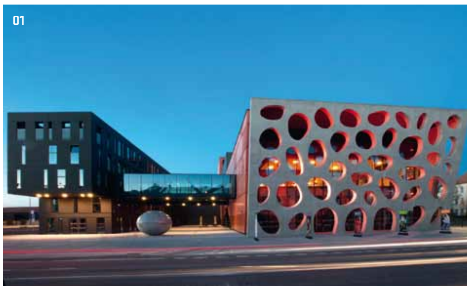
01 &gt; Barevný beton COLORCRETE – červený beton na fasádě Nového divadla v Pízní
