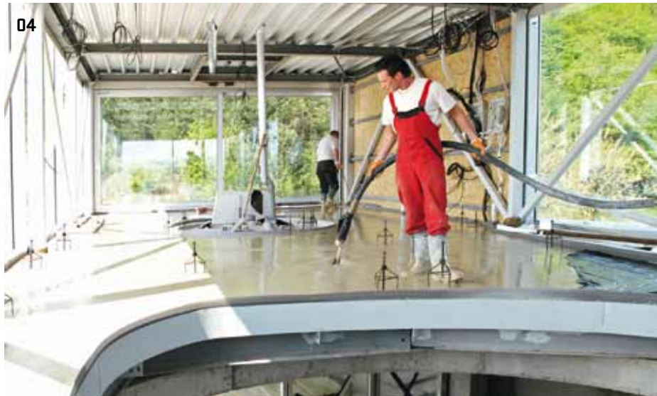
04 &gt; Anhydritová podlaha dokáže teplo přijmout a vydat 2x rychleji
