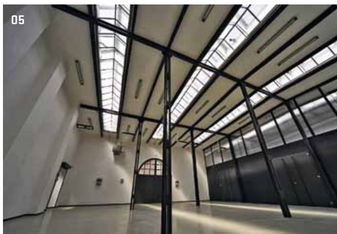
05 > V halách byla zvýrazněna tektonika nosných ocelových konstrukcí
