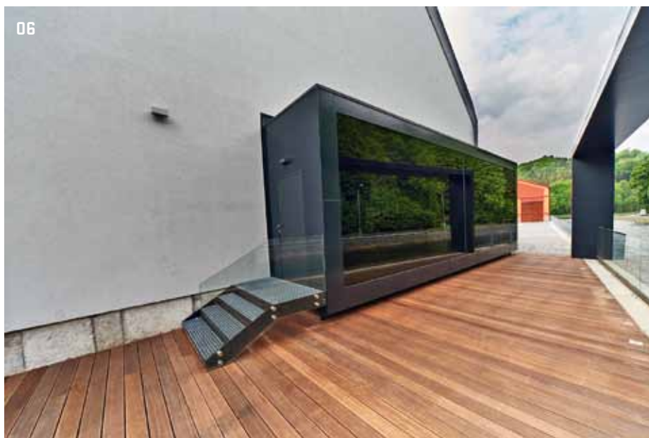
06 > Kovová konstrukce novodobého boxu byla vetknuta do původní stavby
