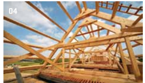
03, 04 > Konstrukci krovu tvoří sedm prostorových segmentů se stanovou střechou, dva koncové prostorové segmenty mají střechu valbovou
