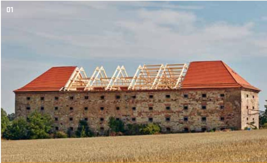
01 > Historická sýpka má čtyři až pět nadzemních podlaží podle sklonu terénu
