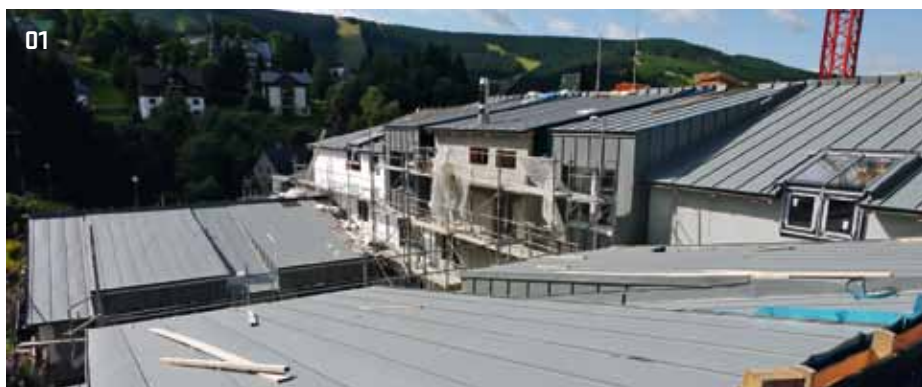
01 > Výrazné členění střešní plochy je patrné pouze při pohledu z horních pater směrem do vnitřního nádvoří anebo přímo ze střechy
