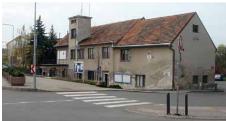
Radnice v Líbeznici před rekonstrukcí
