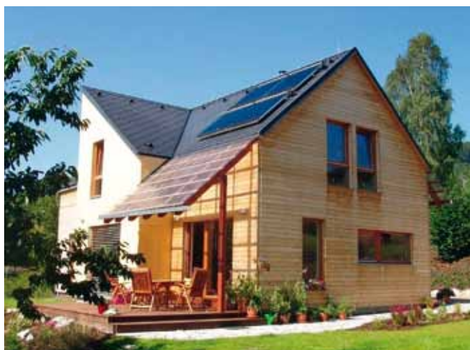
Střecha se sklonem k jihu dává příležitost k instalaci solárního systému. Za vhodných podmínek může být na horách efektivnější než jinde
