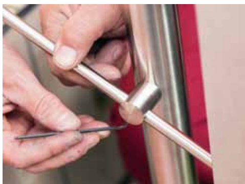
16 Pruty se kotvami vždy prostrčí a poté se zajistí pomocí šroubku a imbusového klíče
