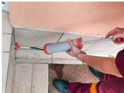
5 Po vyvrtání jsem z otvorů vyfoukal zbytky odvrtného materiálu a veškerý prach
