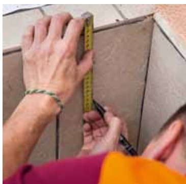
2 Naměřený rozměr rozteče jsem si lihovou fixou přenesl na bok podesty
