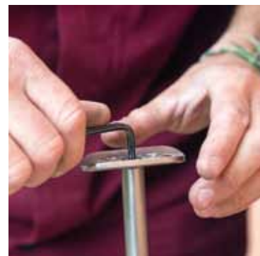
9 Madlo je ke krčkům kotveno ve dvou místech za pomoci šroubků
