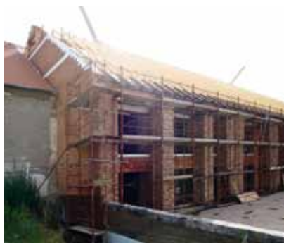
K výstavbě nových budov byly použity zateplené cihly Porotherm T Profi
