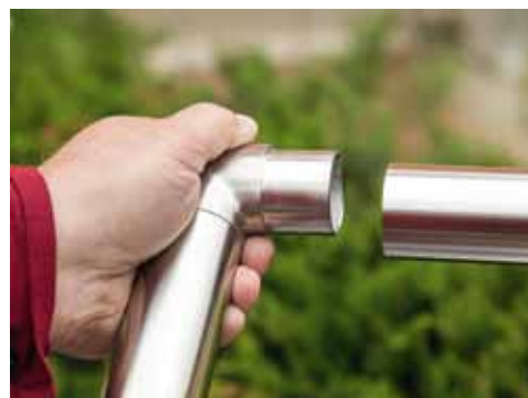
15 K lomení madla slouží tzv. spojky, které přilepíte opět speciálním lepidlem na nerez
