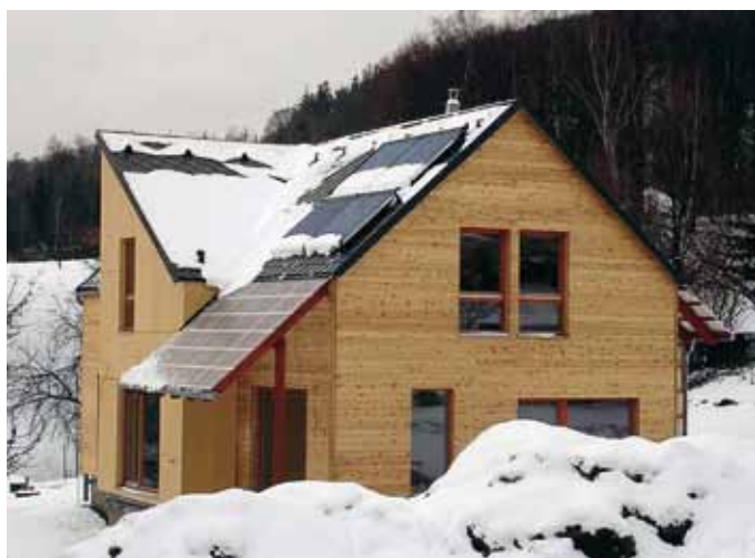
Šikmé střechy s hladkou krytinou a protisněhovými zábranami jsou funkční i moderní (návrh Ing. arch. Pavel Šmelhaus)
