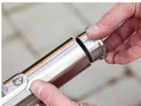
13 Madlo je uzavřeno záslepkou, a to na obou koncích. Jedna ze záslepek těsně před přilepením
