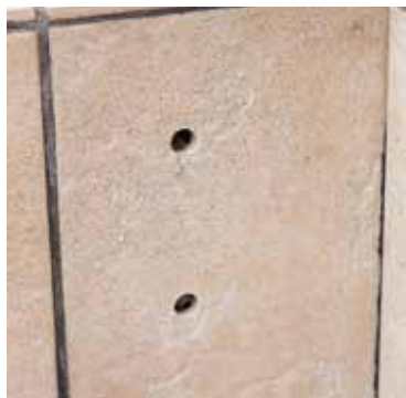
4 Aby dlaždice při vrtání nepraskly, chladil jsem vrták rozprašovačem
