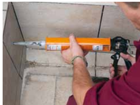
6 Otvory jsem vyplnil ze 2/3 lepidlem (chemickou kotvou), aby zbylo místo pro závitovou tyč
