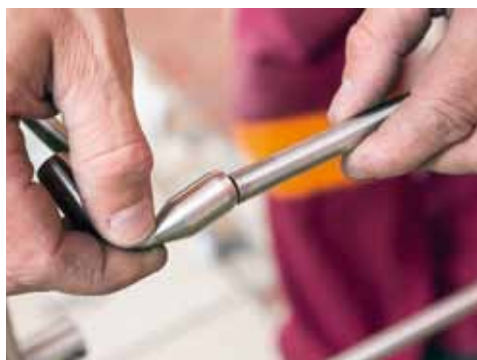
17 Dva kusy prutové výplně jsem spojil pomocí speciálních 3D spojek, které jsou součástí balení
