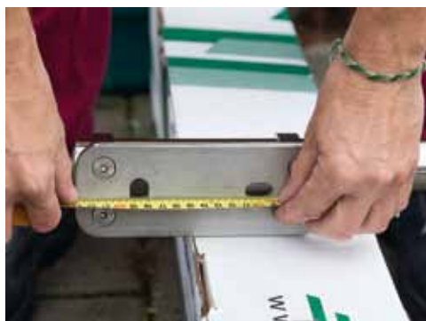
1 Nejprve jsem si změřil rozteče otvorů na patce sloupku a vycházel jsem ze středů otvorů
