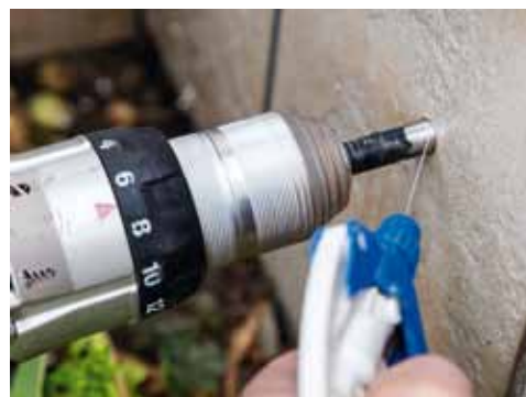
3 Nejprve jsem opatrně ruční vrtačkou provrtal keramiku, až potom jsem nasadil příklepovku
