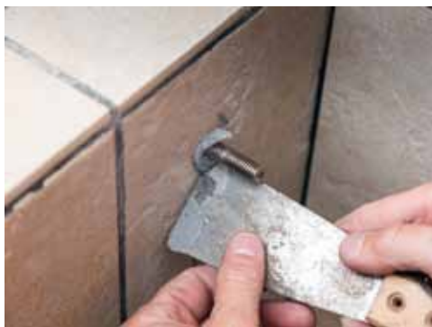
7 Po zasunutí závitové tyče je třeba ihned špachtlí setřít chemickou kotvu vytlačenou z otvoru
