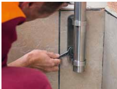
8 Nasadil jsem sloupek na bok podesty do závitové tyče a přišrouboval kloboučkovou maticí
