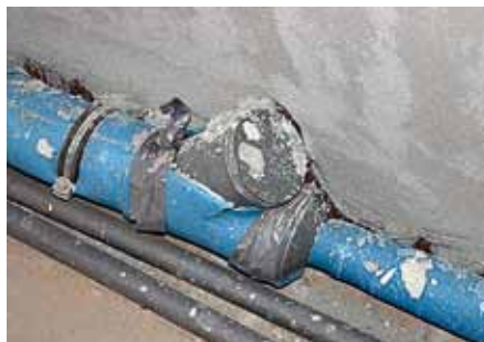
Neoddeliteľnou súčasťou vodoinštalácií sú aj rozvody odpadov a kanalizácie
