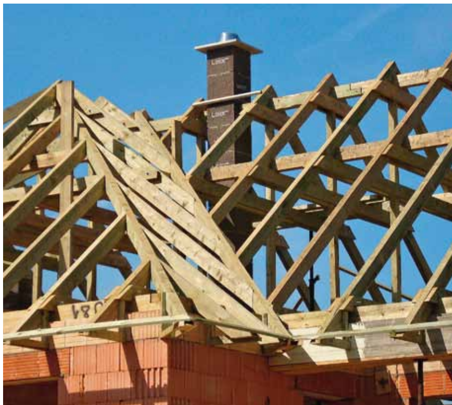
Komínový systém Multikeram LAS je vhodný na pripojenie spotrebičov na rôzne paliva s otvorenou, ale aj uzavretou spaľovacou komorou (LEIER)
