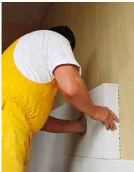
Inštalácia Multiporu je veľmi jednoduchá - dosky sa lepia celoplošne na stenu
