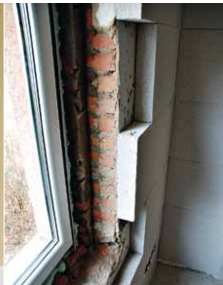
Multipor dobre drží na tehlových stenách, betónoch, ale aj v dreveniciach
