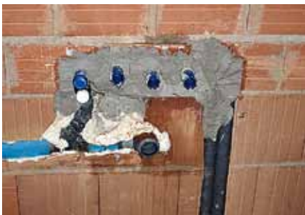
Vodorovné (šikmé) drážky sa v tehlovom murive nerobia, zvislé určujú presné tabuľky výrobcov
