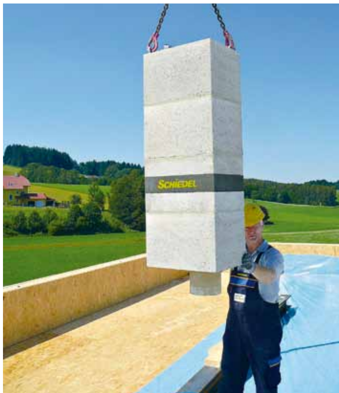
Montáž dvojzložkového komína Schiedel Absolut Xpert, ktorý vyhovuje aj nárokom pasívnych domov (SCHIEDEL)
