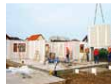
Montáž začína skoro ráno a už popoludní sa môžete prechádzať v dome
