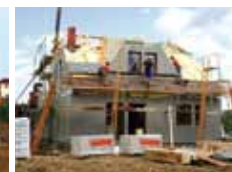
Druhý resp. tretí deň dokončíme strechu a do 30 dní aj kompletný interiéru!
