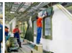
Vložíme izoláciu, osadíme okná a v hale dokončíme aj termofasádu
