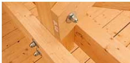
V modernej tesárčine hrá jednu z hlavných úloh celý rad kovových spojovacích prvkov
