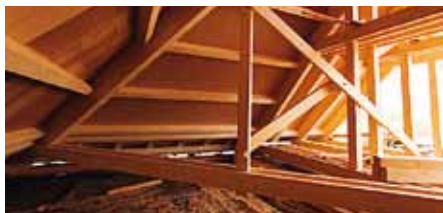
Variant krovovej konštrukcie zostavovanej klasickými tesárskymi postupmi a metódami
