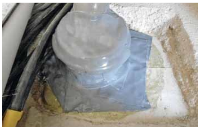
Obr. 10: Detail utěsnění prostupu
