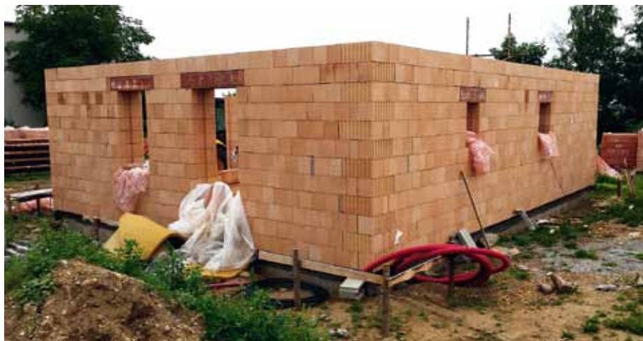
Dokončené zdivo 1. NP
