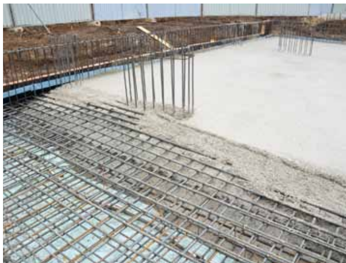
Příprava podkladu, těsnících plechů a ukládka betonu PERMACRETE
