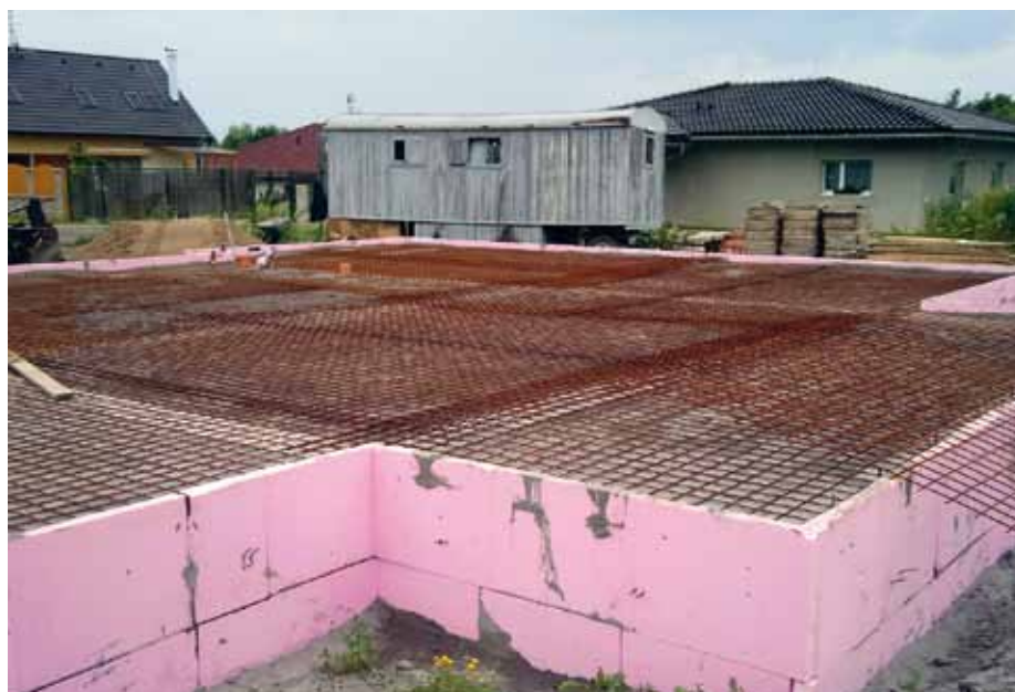
Obr. 4: Příprava na betonáž základové desky
