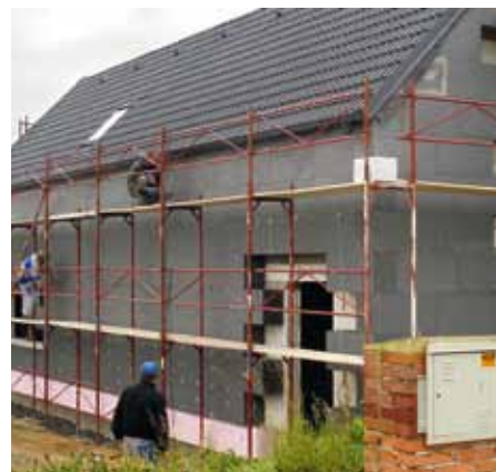
Obr. 8: Instalace izolantu – šedého polystyrenu
