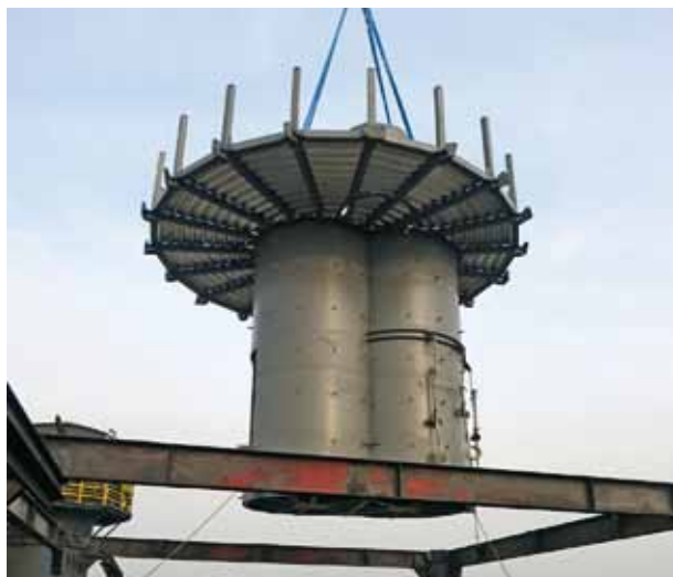
Obr. 2: Osazování vnitřního tubusu
