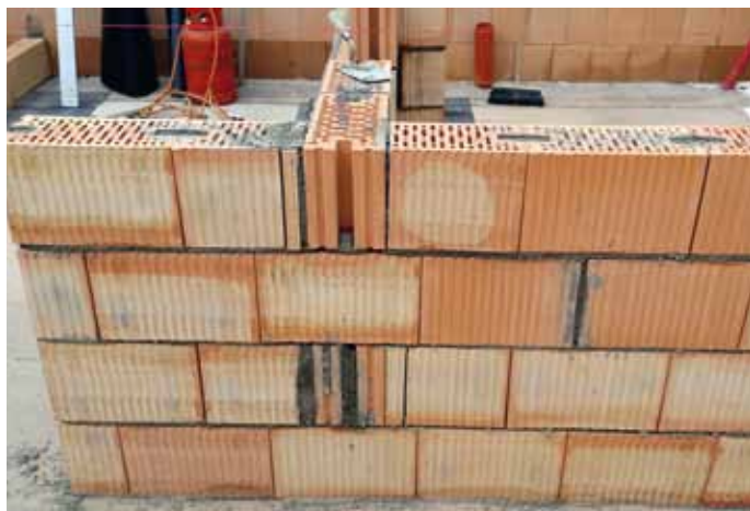
Vnitřní nosná stěna z akustických cihel HELUZ AKU 17,5 MK
