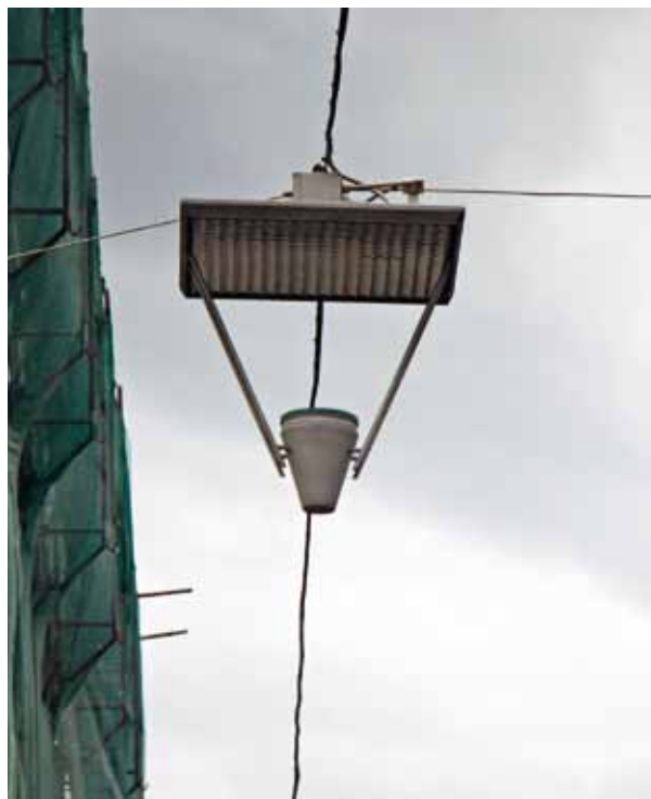
Obr. 7: Prvky veřejného osvětlení ve Štýrském Hradci s rozptylovacími odraznými plochami
