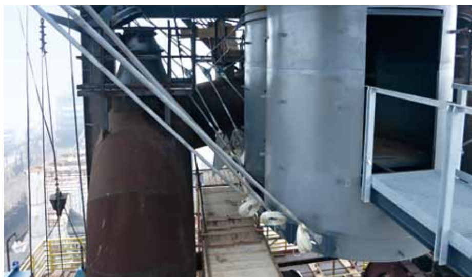
Obr. 5: Zavěšení dolní části vnitřního tubusu
