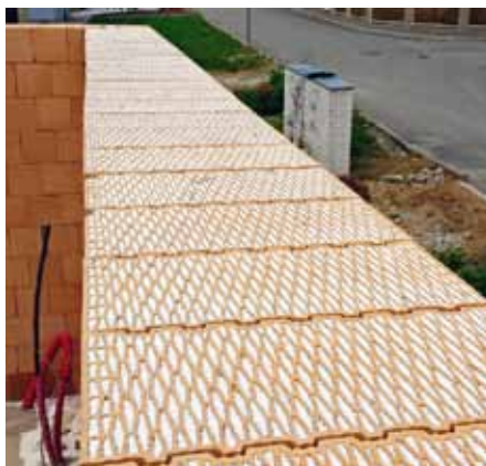
Detail zdiva, cihly HELUZ Family 50 2in1 s integrovaným polystyrenem
