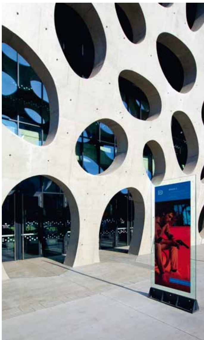
EASYCRETE® – pohledový beton na vstupní oponě Nového divadla v Plzni
