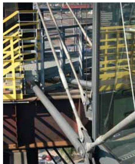
Obr. 7: Nosná konstrukce před montáží opláštění
