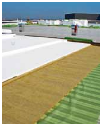
Systém PROTECT ROOF® zahrnuje variantní řešení střech s minerálními izolacemi, pěnovým polystyrenem a PIR
