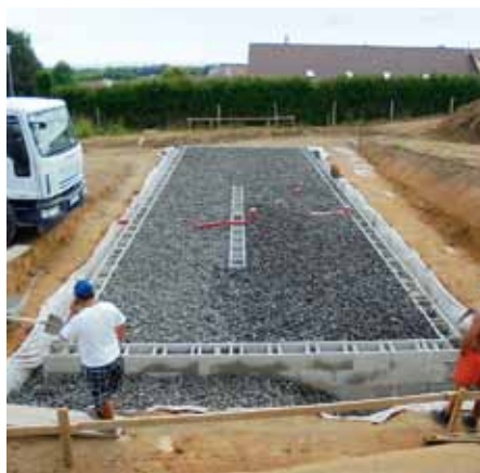
Obr. 3: Izolace základové desky vrstvou pěnového skla Refaglass
