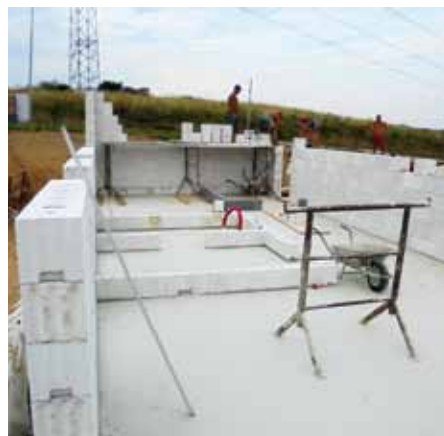
Obr. 4: Nosné zdivo KMB Sendwix v přízemí
