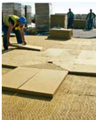
Systém PROTECT ROOF® zahrnuje variantní řešení střech s minerálními izolacemi, pěnovým polystyrenem a PIR
