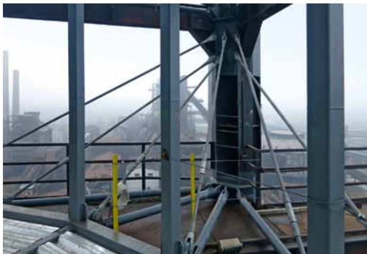
Obr. 3: Zavěšení v patě konstrukce vnějšího tubusu
