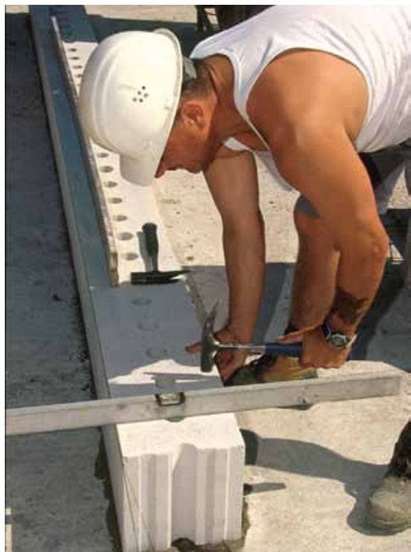
Základem je přesné zhotovení patní vrstvy zdiva, zde tl. 240 mm
