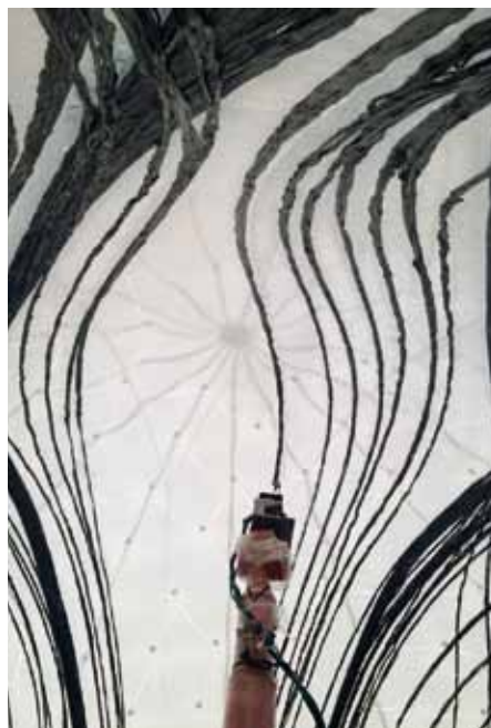
Obr. 5: Lepení uhlíkové výztuže
