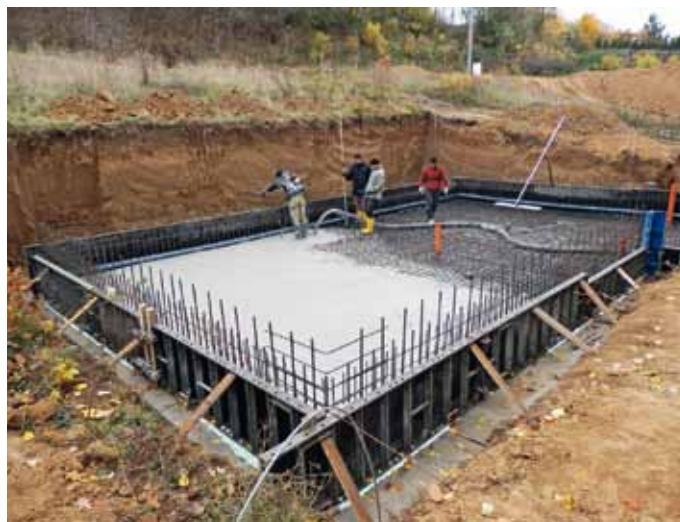
Betonáž základové desky bílé vany RD z PERMACRETU
