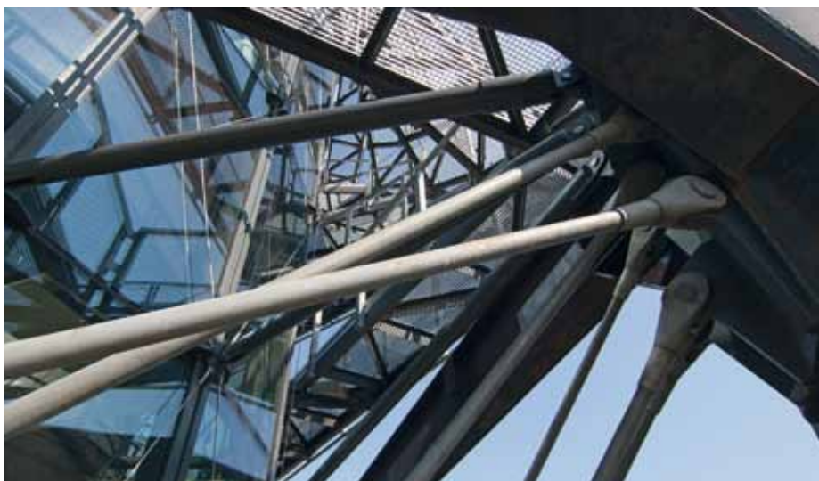
Obr. 8, 9: Zavěšení na dolní hraně vnějšího tubusu po dokončení
