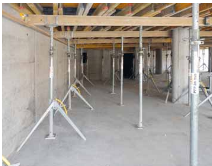
Hotové konstrukce desky a stěn bílé vany z PERMACRETU
