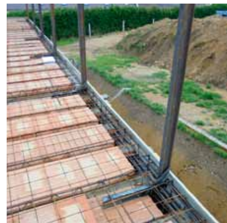
Obr. 5: Stropní konstrukce nad 1. NP
