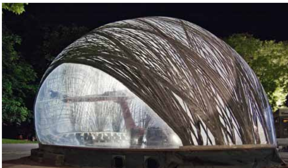
Obr. 6: Konstrukce nedlouho před dokončením instalace výztužných vláken
