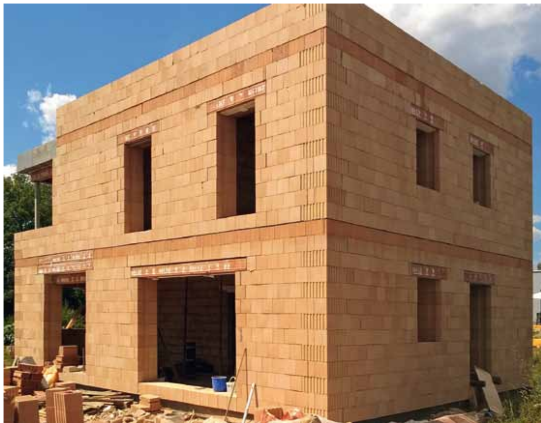
Dokončená hrubá stavba
