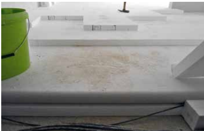
Obr. 11: Tepelná izolace (EPS) v podlaze přízemí
