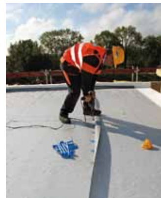
Lehké požárně odolné střechy PROTECT ROOF® prošly náročnými požárními zkouškami na zkušebně PAVUS a plně rozvinutému požáru uvnitř budovy odolávají více než 45 minut
