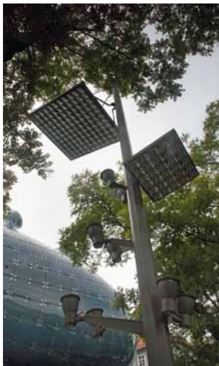
Obr. 7: Prvky veřejného osvětlení ve Štýrském Hradci s rozptylovacími odraznými plochami
