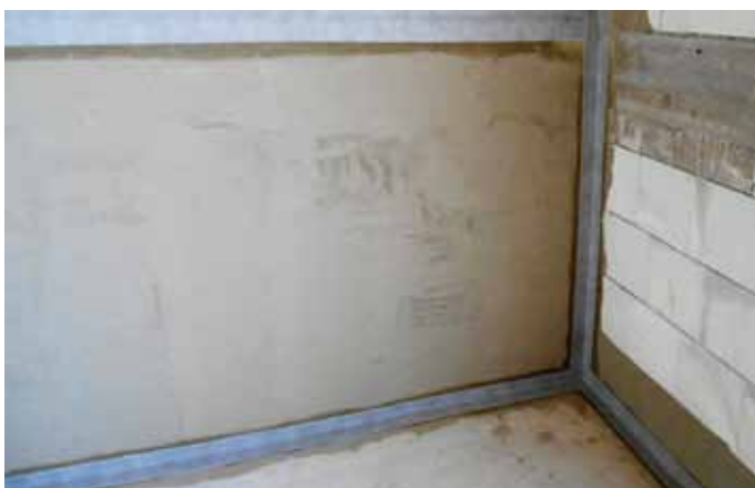
Obr. 9: Zajištění vzduchotěsnosti
