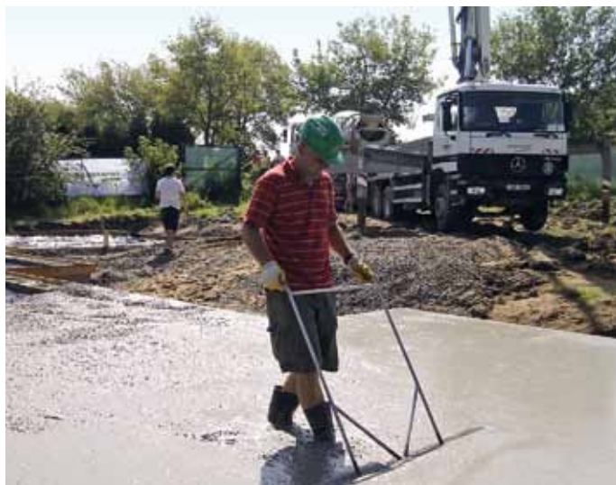
STEELCRETE® – realizace základové desky
