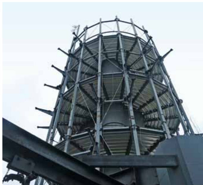
Obr. 7: Nosná konstrukce před montáží opláštění
