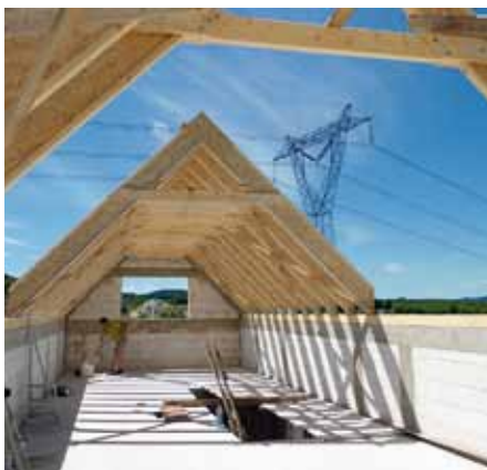
Obr. 7: Konstrukce krovu
