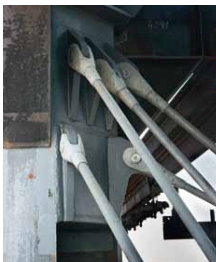
Obr. 4: Detail uchycení táhel v původní konstrukci vysoké pece
