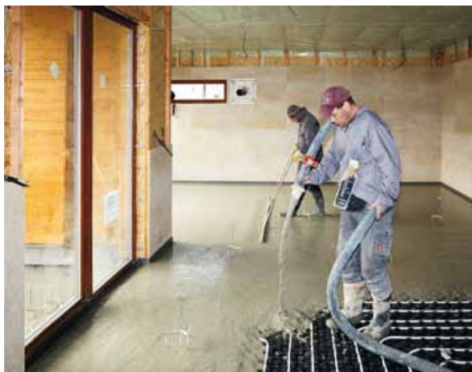
CEMFLOW® – litý cementový potěr, realizace podlahy v dřevostavbě
