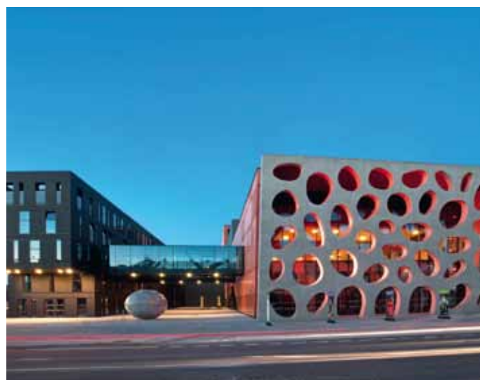
COLORCRETE® – využití červeného betonu na fasádu Nového divadla v Plzni
