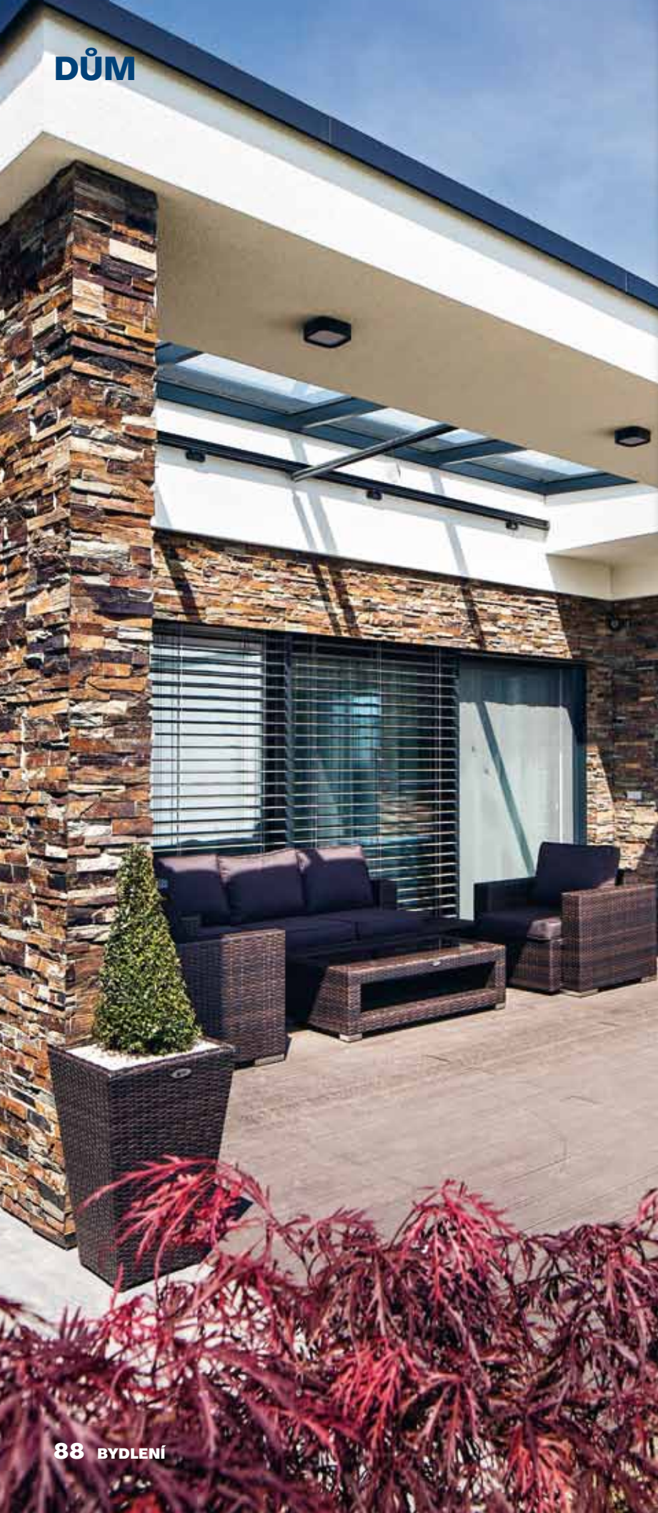
Detail screenových rolet. Horní je osazena horizontálně pod zasklenou plochou markýzy, druhá svisle na jihozápadní straně. Jejich součinností vzniká na terase příjemné příšeří nebo sem naopak jde sluníčko
