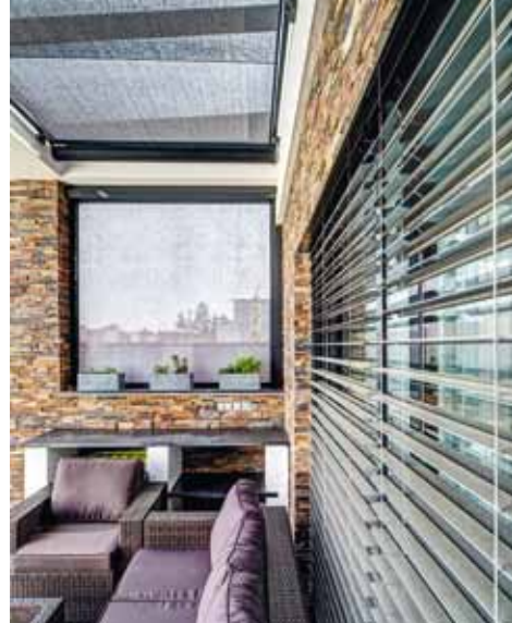
Detail screenových rolet. Horní je osazena horizontálně pod zasklenou plochou markýzy, druhá svisle na jihozápadní straně. Jejich součinností vzniká na terase příjemné příšeří nebo sem naopak jde sluníčko
